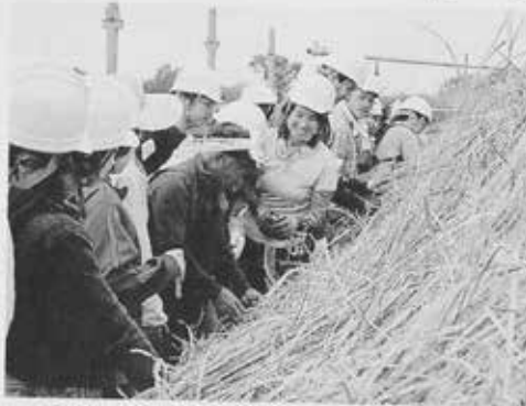
移築した民家のかやぶき作業。材料のかやは「やさど茅葺き屋根保存会」が協力したつくば市臼井で10月14日
