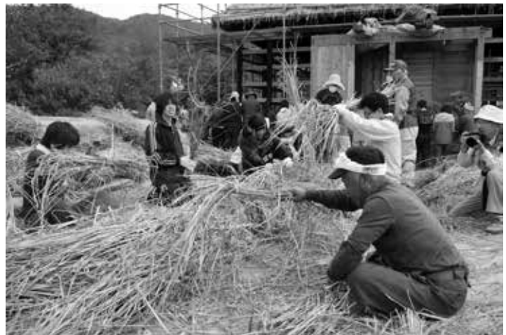
左) 足場上がり実際の屋根を葺きます。親子での参加も見られました 下) 茅を束ね直す小まるきは、たいせつな下準備
