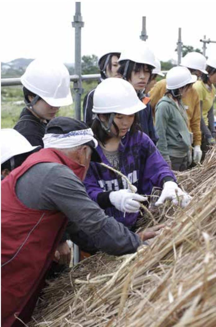
左) 縄結びと平葺きの基本を体験 右) 並べた茅を足で踏みつけて締め込みます。「これができるれば体は柔らかいよ」
