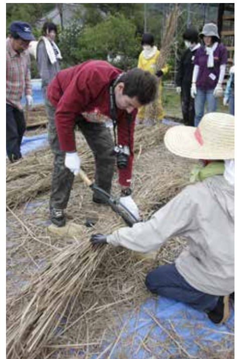
左) 屋根に茅を上げる前の下準備。小まるきの方法を88歳の職人に教わります。「慣れれば誰でもできるよ」 右) 束ねた茅束を押し切りで切り揃えます
