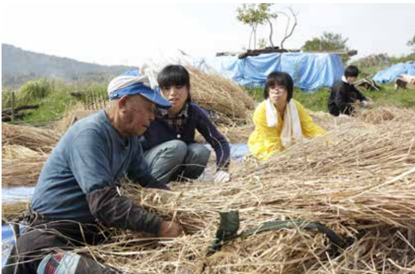
左) 屋根に茅を上げる前の下準備。小まるきの方法を88歳の職人に教わります。「慣れれば誰でもできるよ」 右) 束ねた茅束を押し切りで切り揃えます
