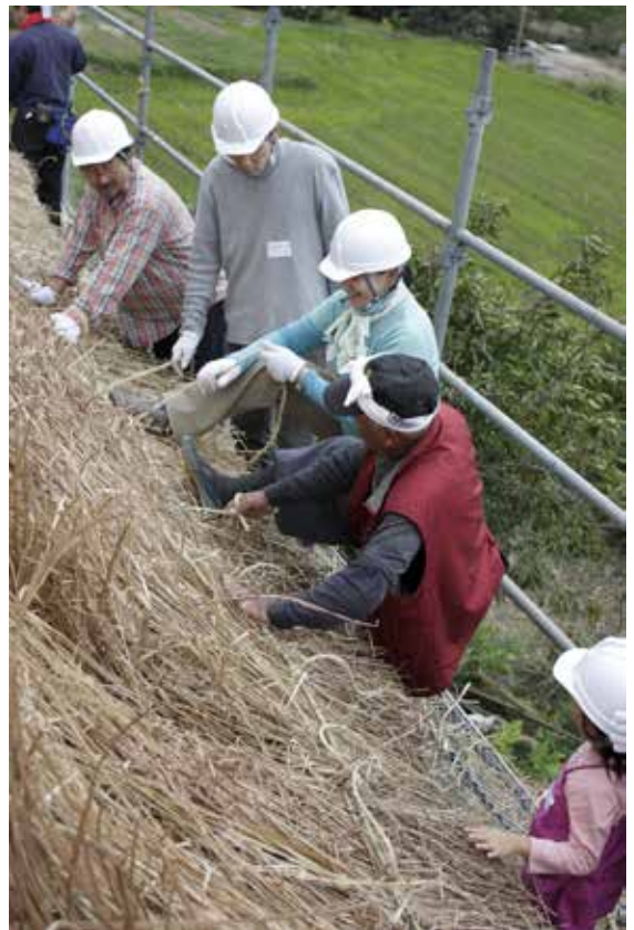
左) 縄結びと平葺きの基本を体験 右) 並べた茅を足で踏みつけて締め込みます。「これができるれば体は柔らかいよ」
